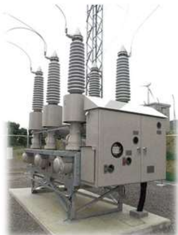
タンク形ガス遮断器 (GCB.66~120kV)
